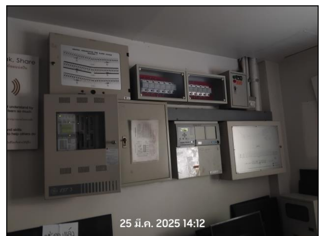
รูปที่ 2.17 Graphic Fire Alarm
