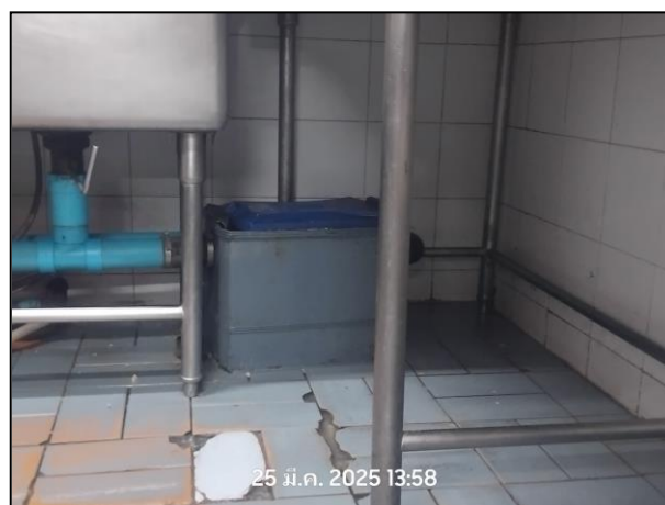
รูปที่ 2.2 ถังตกไขมันใต้อ่างล้างจาน
